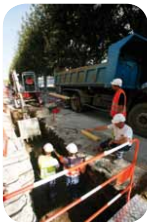
Dévoiements de réseaux sur le Quai Veil Picard
