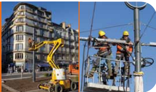
Pose des lignes aériennes de contact
