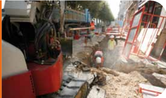
Dévoiement de réseaux
