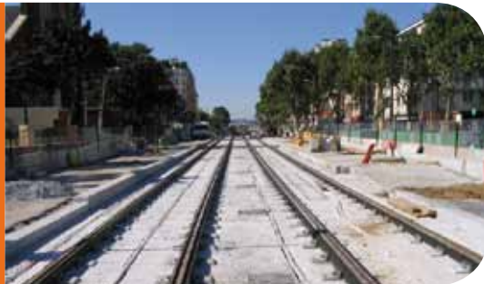
Travaux de plateforme
